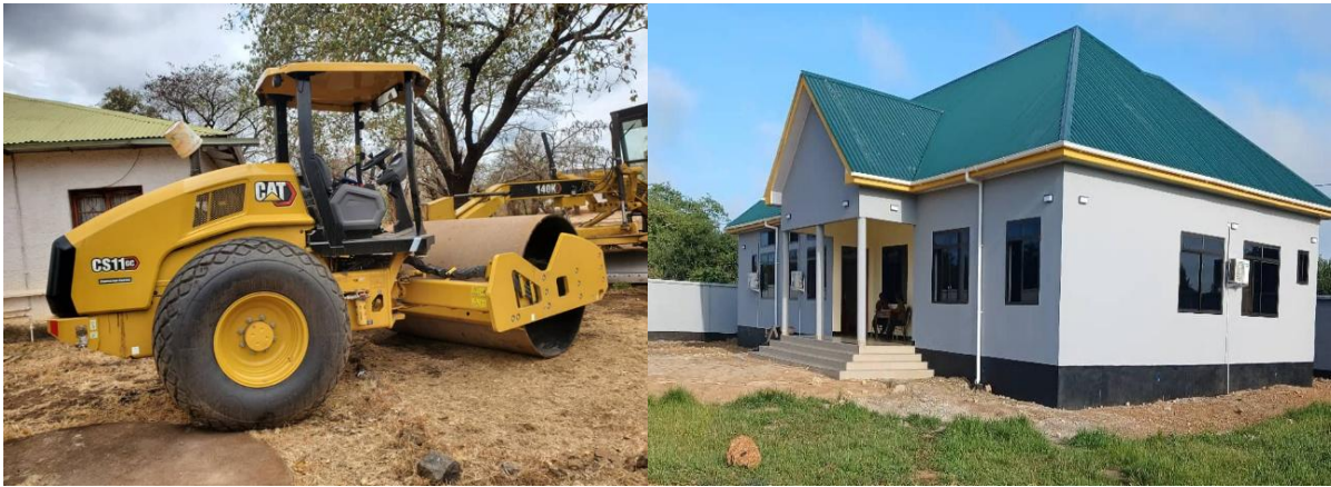
Mitambo ya ujenzi wa barabara na jengo la ofisi ya Pori la Akiba Muhesi.
